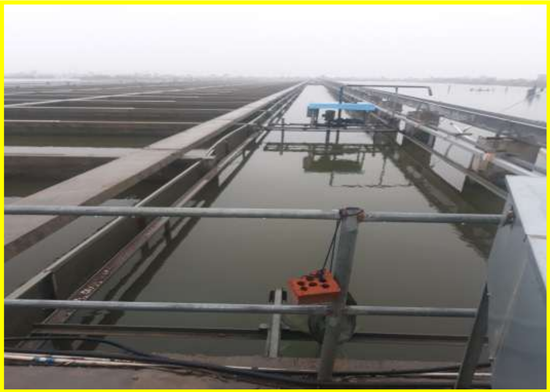
مقطع أمامي للأحواض الكونكريتية يستعمل لتنظيف الفضلات
